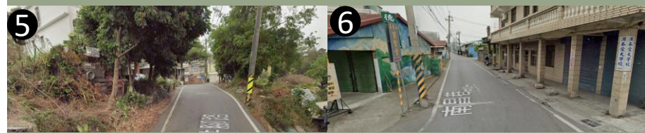
井腳產業道路建議擴大路段起迄點現況
